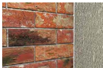
Juntas entre distintos muros
