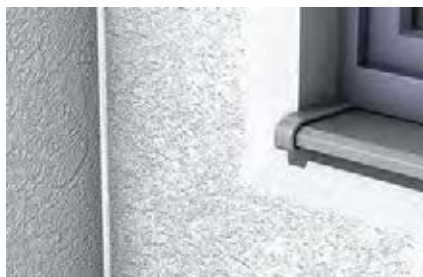
Juntas en paredes exteriores
