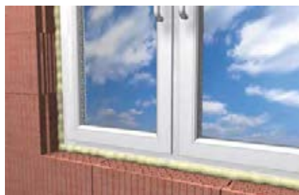
Juntas en instalación de aberturas
